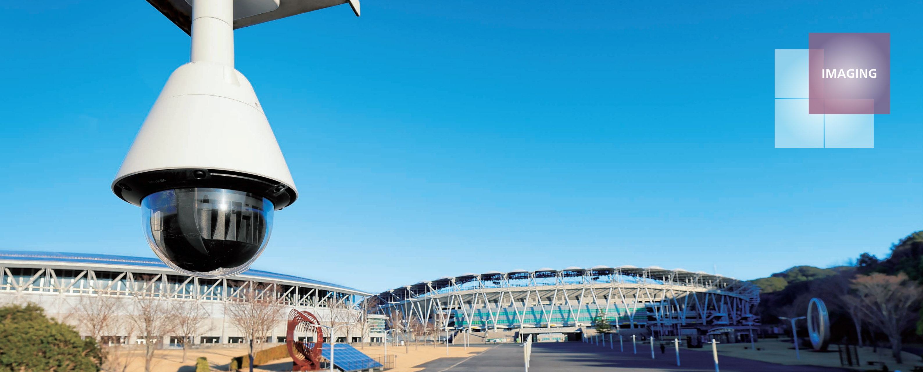
Le telecamere di rete ad alte prestazioni Canon sorvegliano i visitatori che si dirigono verso l'arena (a sinistra) e lo stadio (a destra) dalla stazione JR Aino
