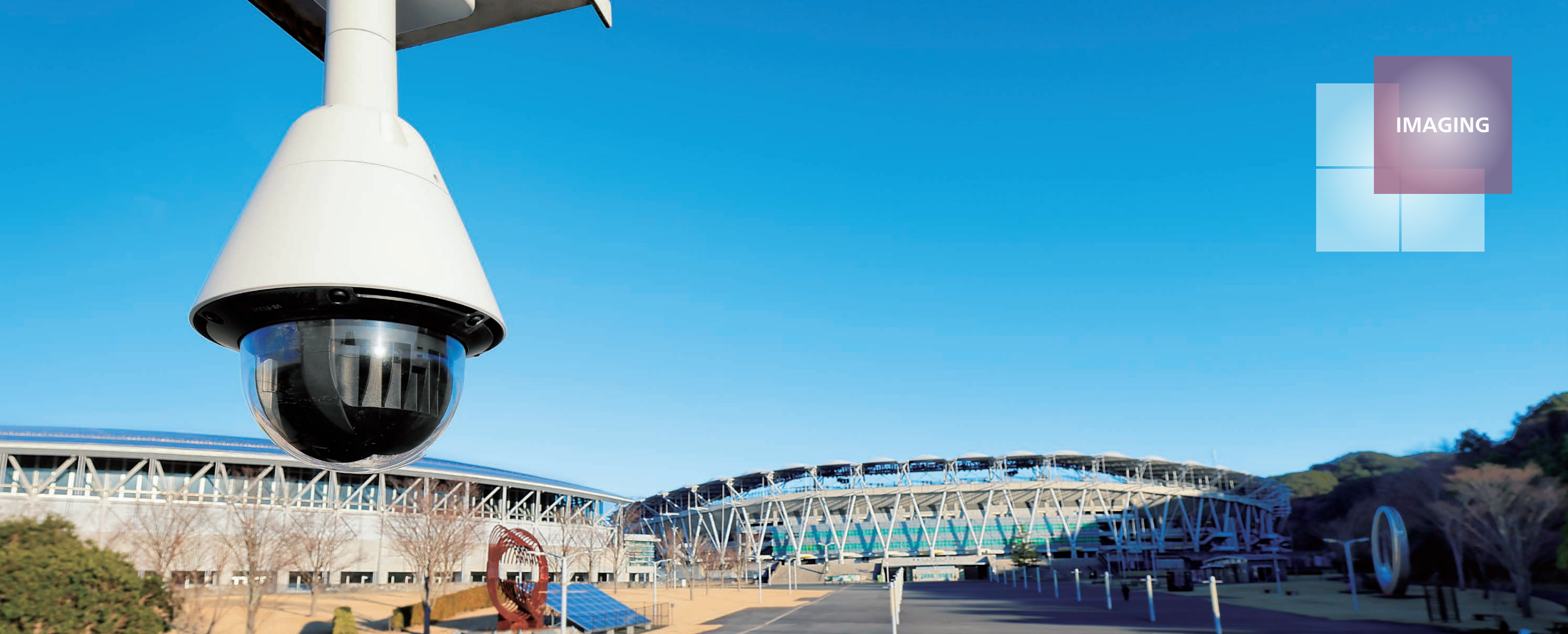
Las cámaras en red de alto rendimiento de Canon se encargan de vigilar a los visitantes que se dirigen al pabellón cubierto (izquierda) y al estadio (derecha) desde la estación JR Aino.
