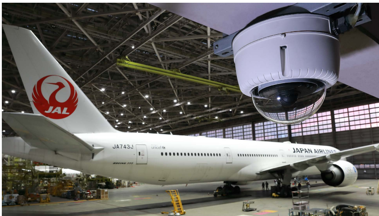
ネットワークカメラが導入されている羽田空港のJAL格納庫
