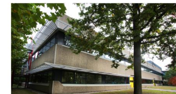
地下水熱利用空調システム (オセ社)
