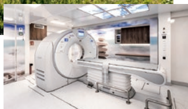
コンテナ内に設置されたCT装置
