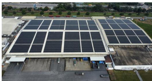
キヤノンベトナム・タンロン工場に設置している太陽光パネル
