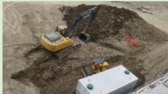
雨水の循環利用システムの導入準備風景
