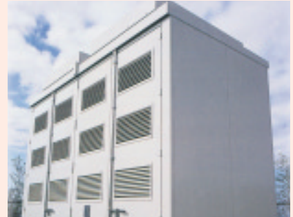
夜間電気を有効利用できる電力貯蔵用電池(NAS電池)を平塚事業所と矢向事業所で導入
