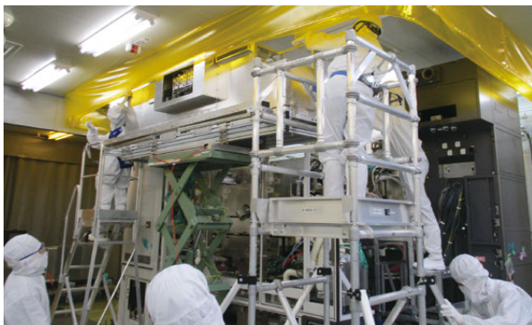
装置の設置作業
