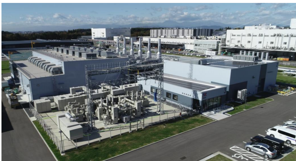
清原スマートエネルギーセンター
