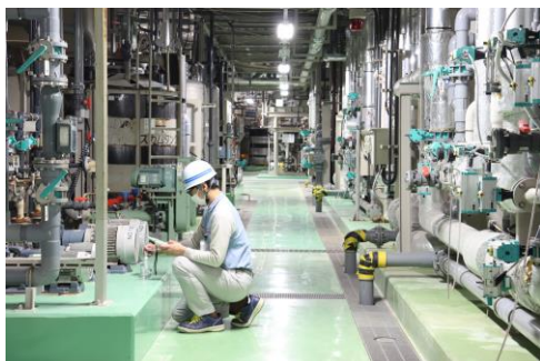
排水完全クローズドシステム整備の様子
