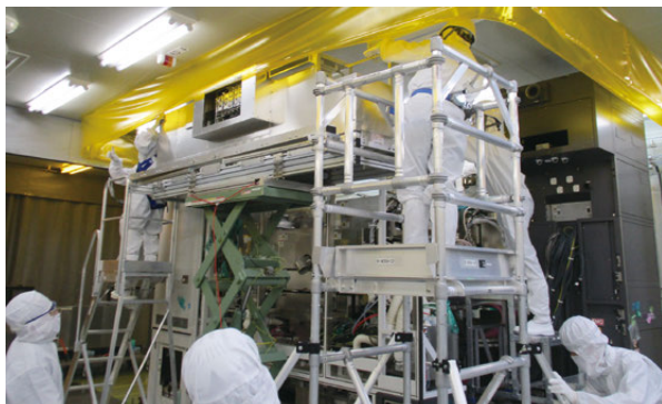
装置の設置作業
