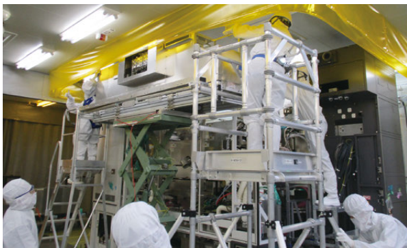
装置の設置作業
