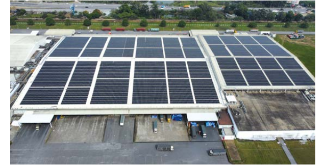
キャノンベトナム・タンロン工場に設置している太陽光パネル
