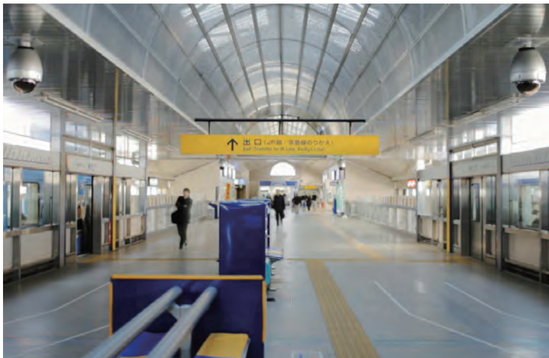
ネットワークカメラが設置された駅のホーム
