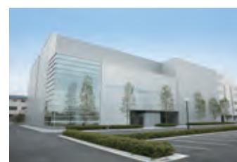
玉川総合測定試験棟
