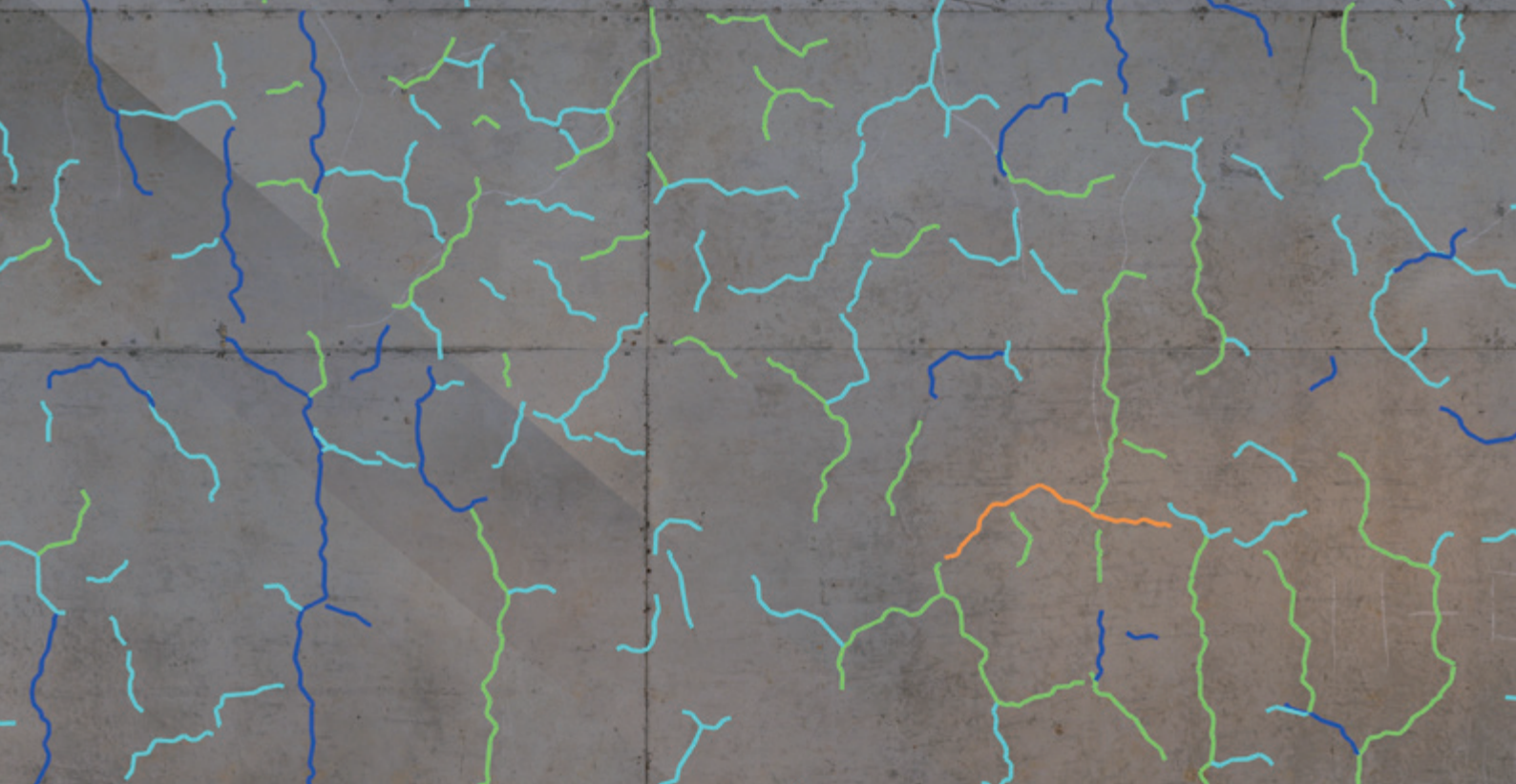
AIによるひび割れ検知結果
